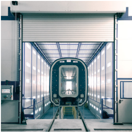
➤ Cabine di verniciatura di grandi dimensioni
