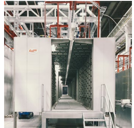
➤ Durchlauf Waschtunnel Heißentfettung, 2 Spülungen + VE-Spüle
